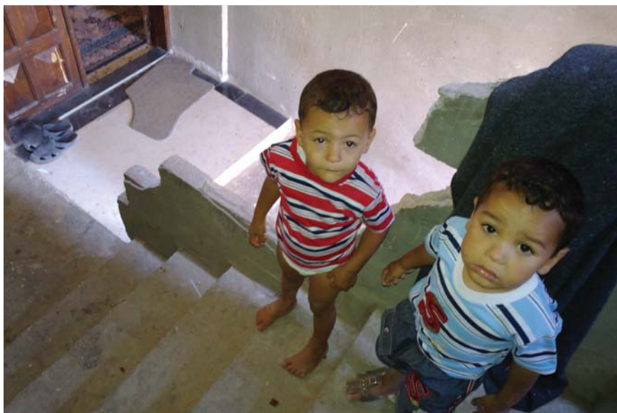
Damaged Stairs in Beit Lahia | UUSC
